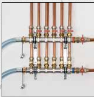
Flussaggio di sistemi radiatori e di riscaldamento di superfici (S/SL/SLW)
